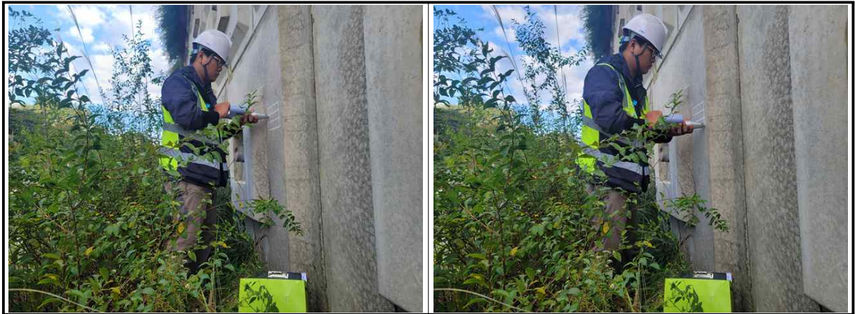
【그림 5.3.6】 슈미트해머를 이용한 반발경도시험 전경
